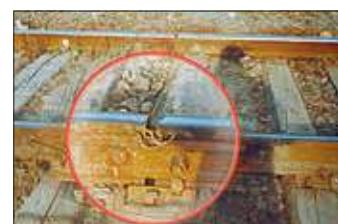
3.15. Зазоры между железнодорожными рельсами
